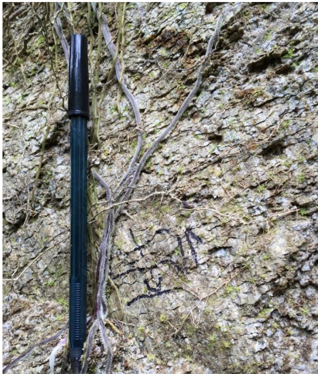
Figura 65. Fuerte fracturamiento en las paredes del cerro Sak'abaj
