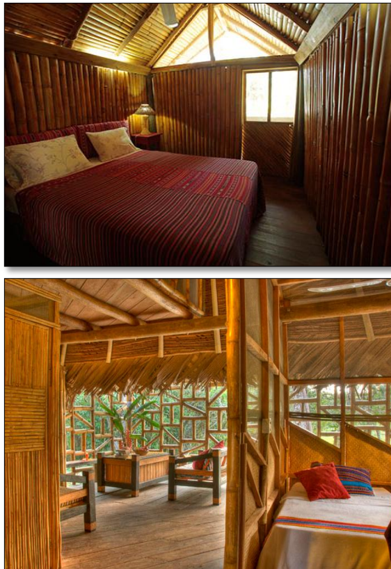
Figura 23. Habitaciones construidas con bambú
