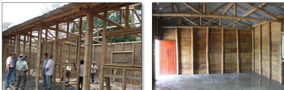
Figura 26. Construcción de la escuela del bambú
