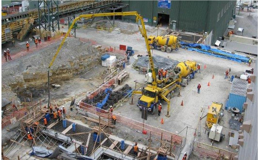
Figura 3. Manejo de concreto premezclado
