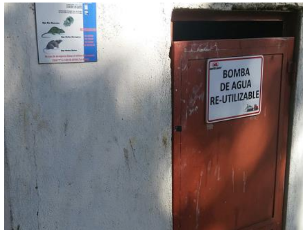
Figura 29. Instalaciones para el manejo de agua en producción de concreto premezclado, planta 1
