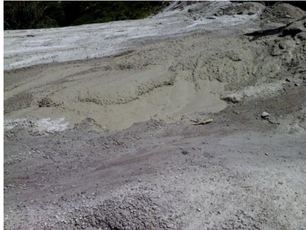
Manejo de lechadas de lavado camiones (concreto residual)
