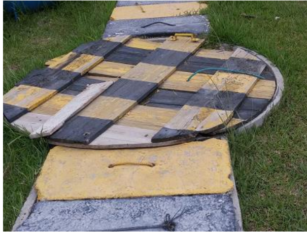
Tanque de almacenamiento subterráneo para agua
