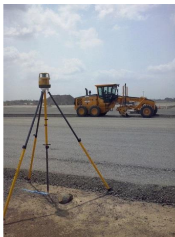
Figura 28. Transmisor milimétrico enviando señal a motoniveladora, Aeropuerto Tocumen, Panamá
