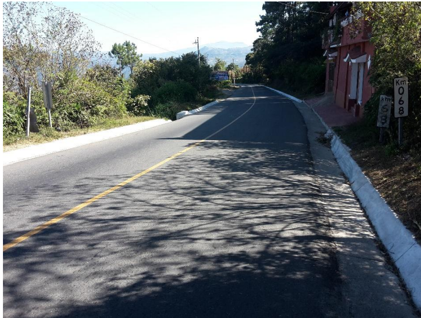
Figura 7. Proyectos de limpieza del derecho de vía (kilómetro 68)
