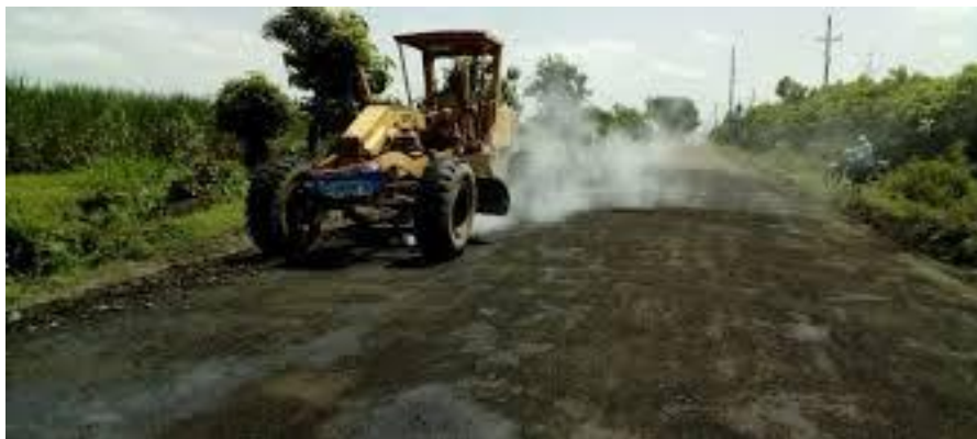
Figura 3. Proyectos de tramos no pavimentados (A)
