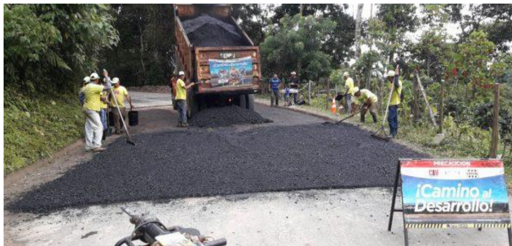
Figura 2. Proyectos de tramos pavimentados (B)
