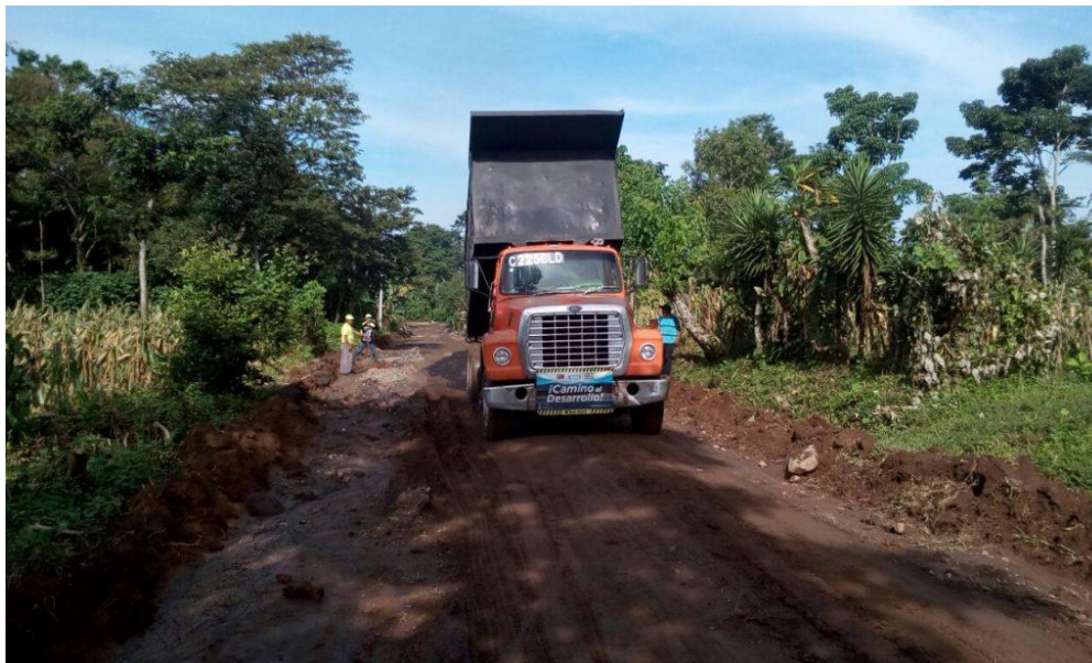
Figura 4. Proyecto de tramos no pavimentados (B)
