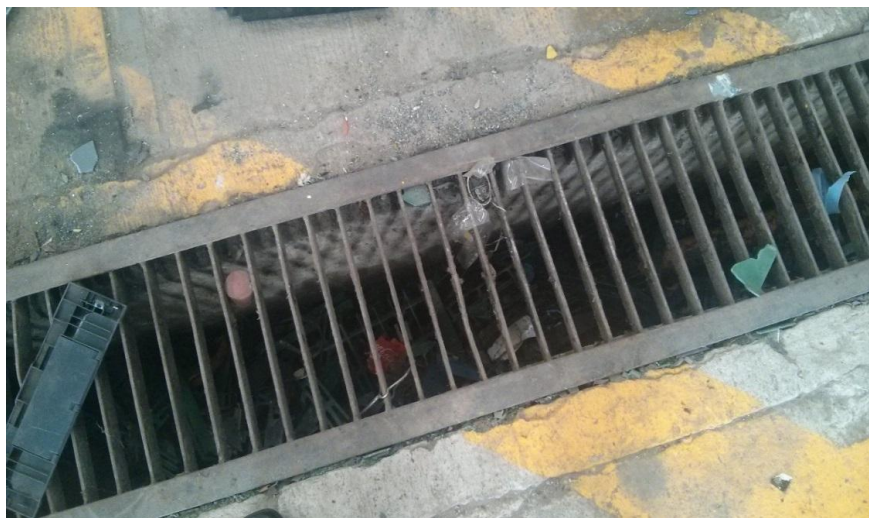
Figura 17. Drenaje de agua
