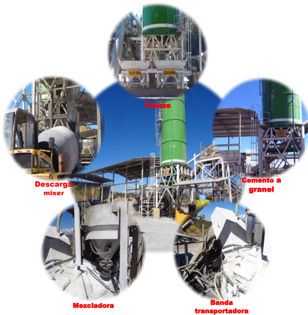
Figura 21. Planta central concreto lanzado
