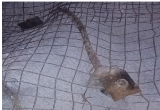
Figura 7. Perno de anclaje con placa
