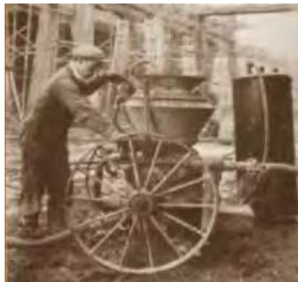
Figura 2. Pistola para cemento con doble cámara
