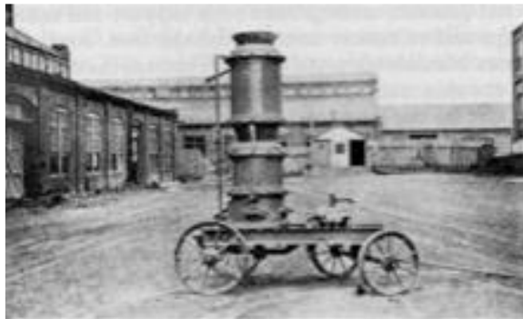
Figura 1. Equipo de concreto lanzado inventado por Carl Ethan Akeley
