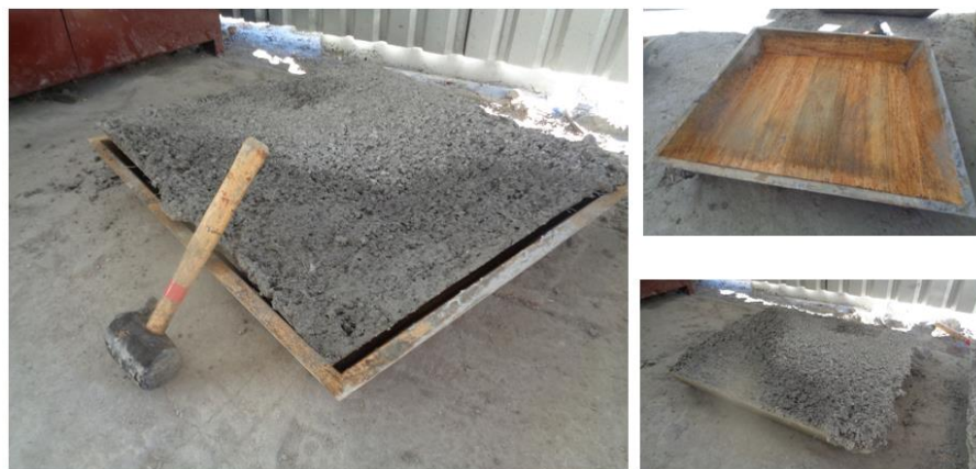
Figura 25. Desencofrado
