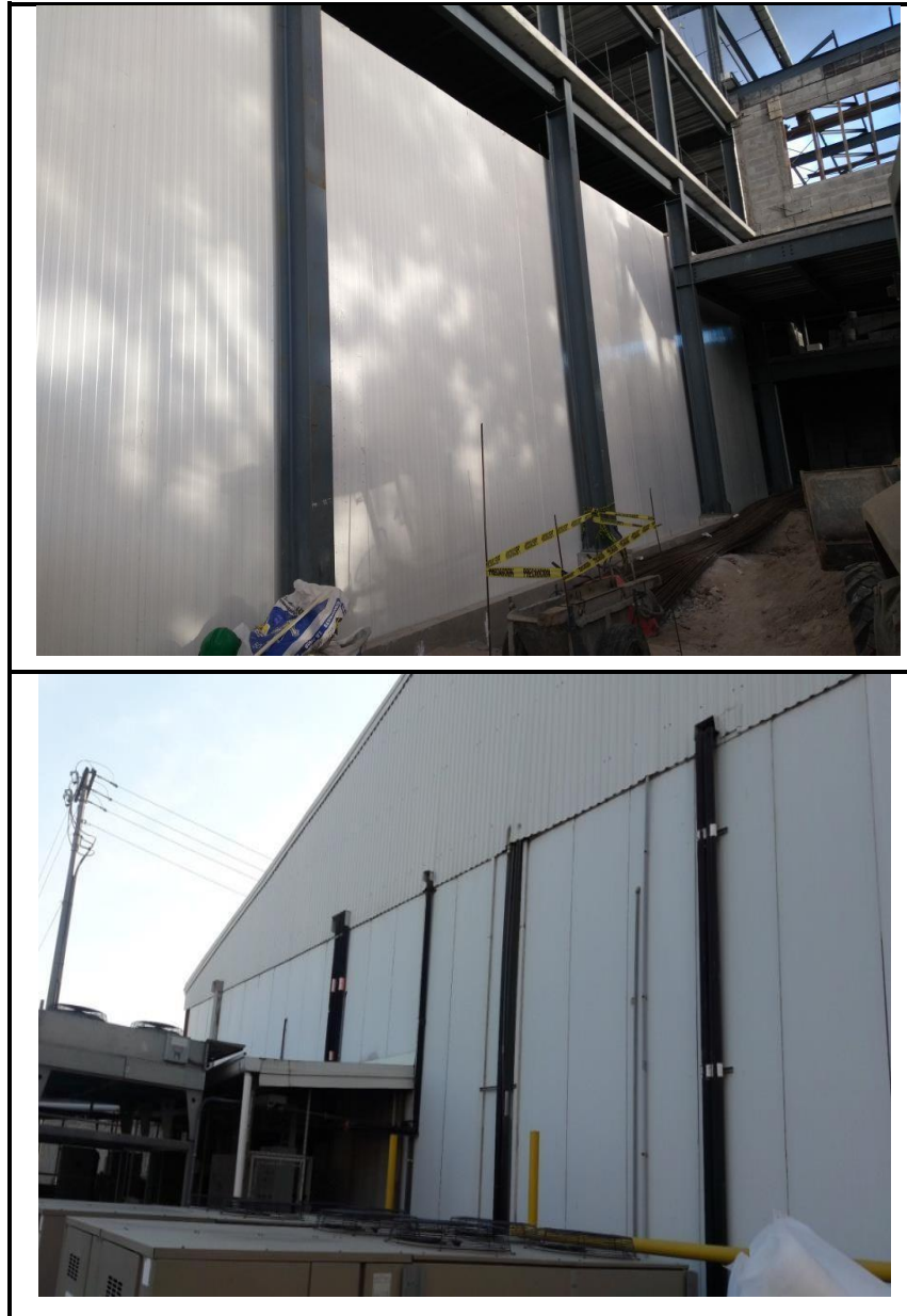
Figura 24. Vista exterior de muros de cuarto frío
