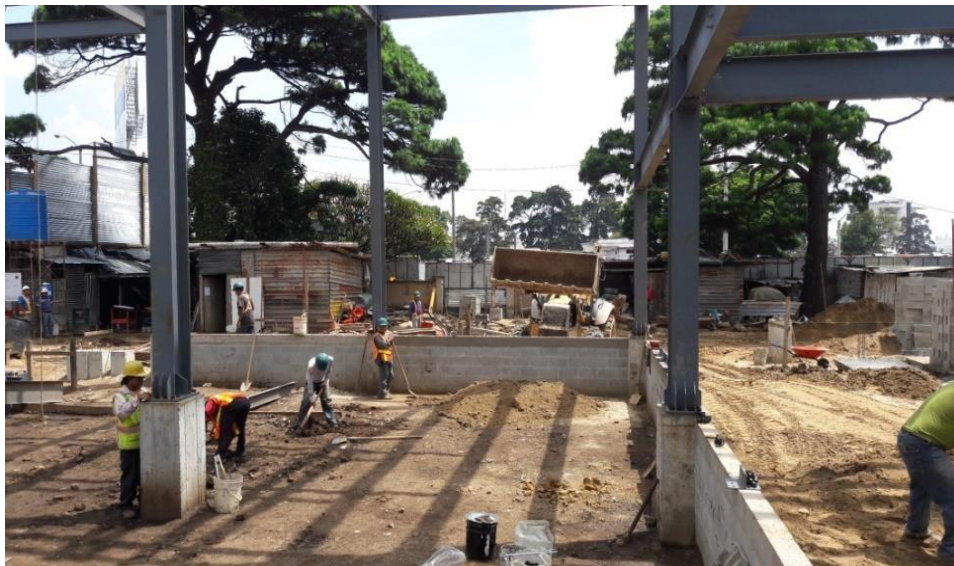
Figura 12. Conformación base desuelo en cuarto frío
