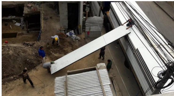
Figura 21. Manejo de paneles en obra
