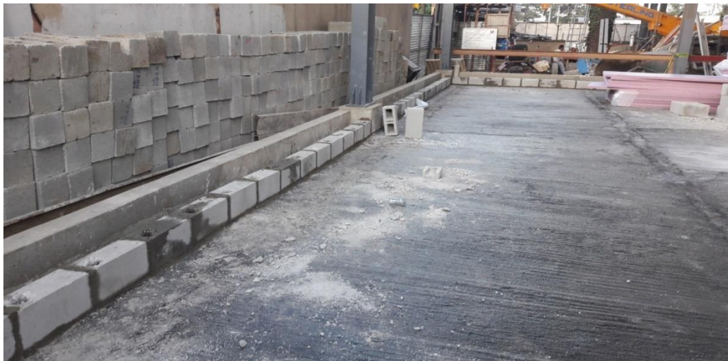
Figura 32. Construcción de muretes para estanqueidad del cuarto frío
