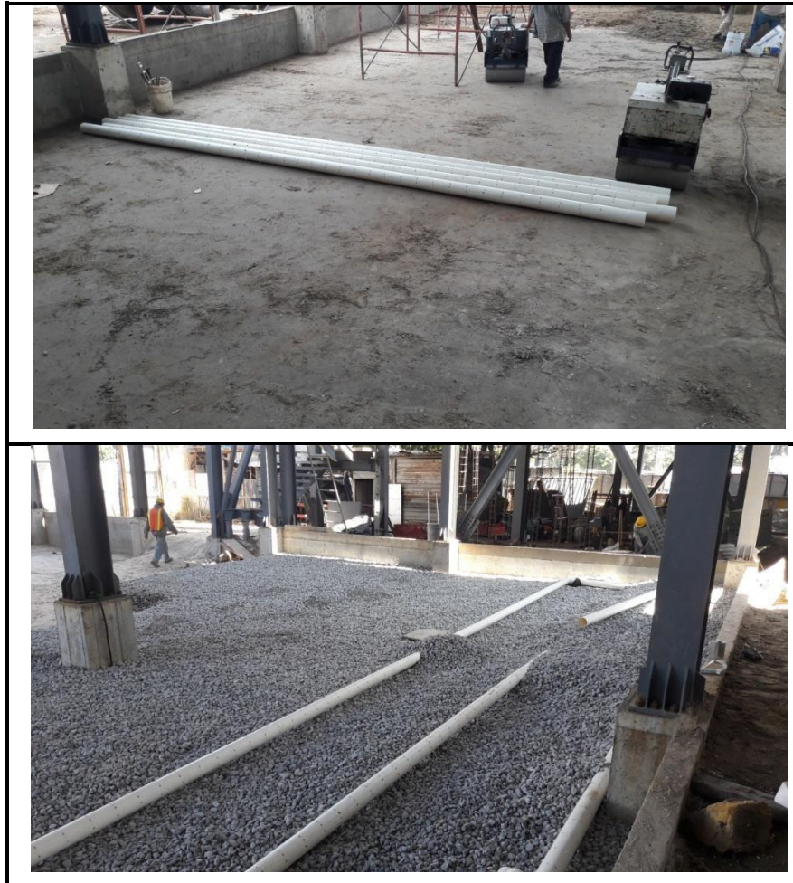
Figura 18. Vista de instalación de drenajes de cuarto frío
