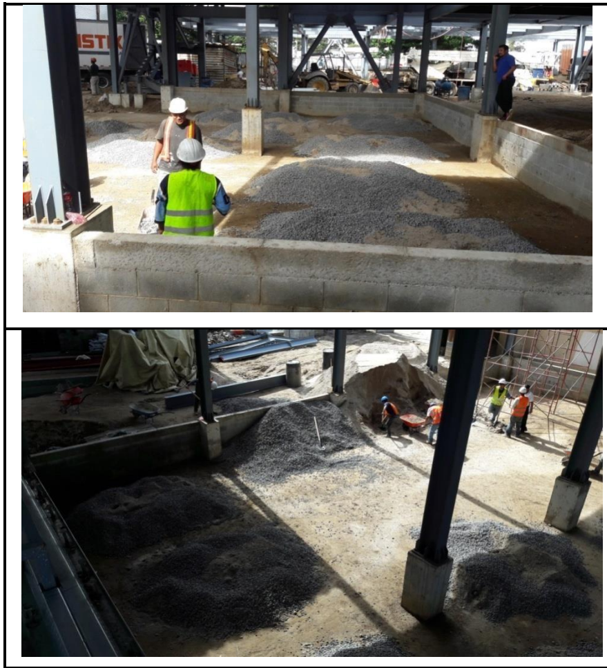
Figura 17. Base de grava para piso de cuarto frío T \leq 0^{\circ}\text{C}
