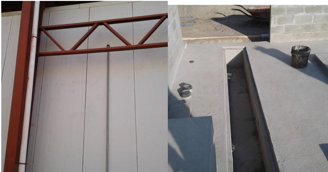
Figura 34. Detalles de drenajes de cuarto frío
