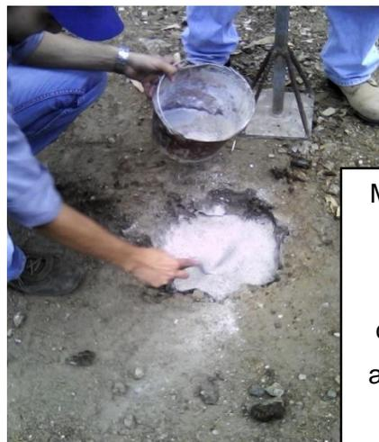
Mezcla de suelo y cal para estabilizar el suelo (colocar 3 capas), aumentando así el nivel de pH (ver tabla XX).
