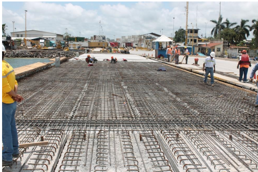
Figura 19. Fundición de losa
