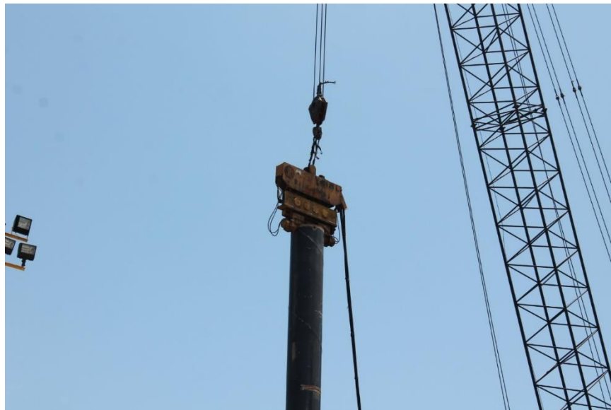
Figura 21. Hincado inicial con vibrador
