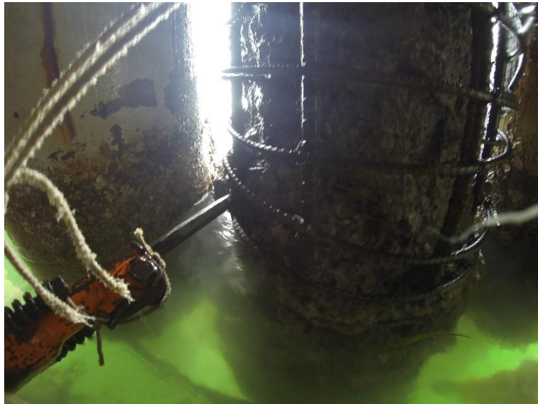
Figura 15. Demolición con herramientas neumáticas
