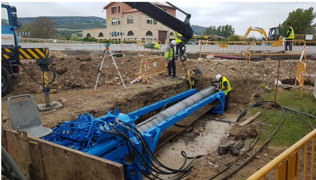
Figura 25. Hincado horizontal
