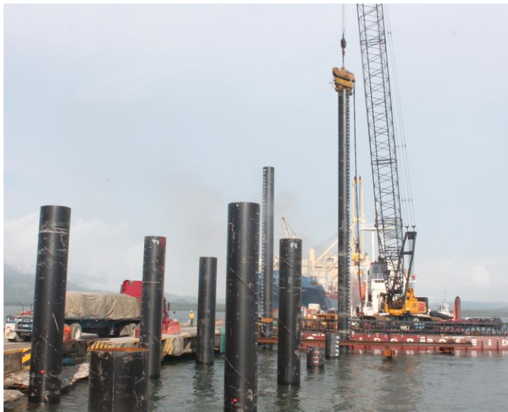
Figura 16. Pilotes de acero
