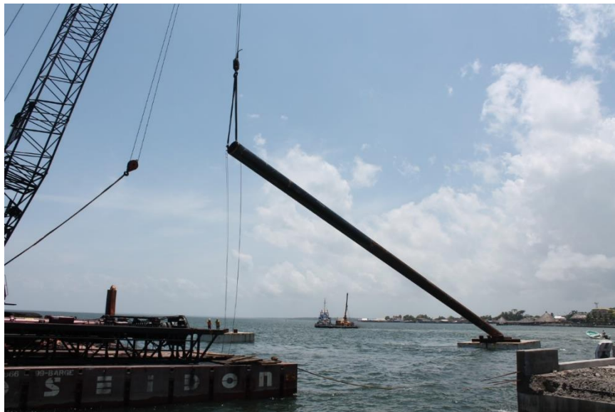
Figura. 20. Izaje de pilote
