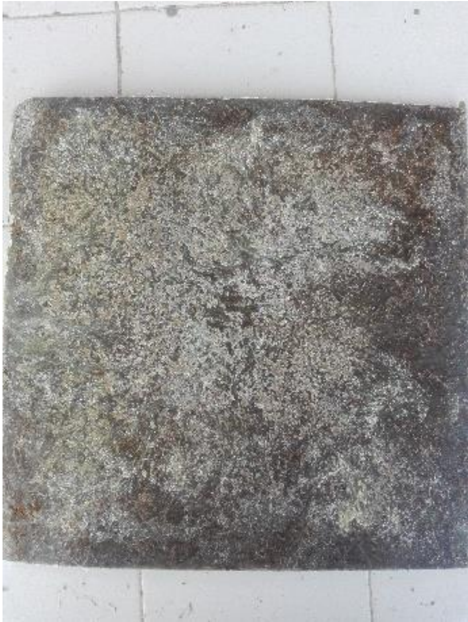
Figura 69. Exceso de anhidrita
