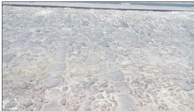
Figura 2. Calle con cinta colocada en ambos sentidos
