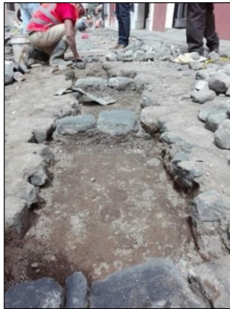
Figura 13. Colocación de rocas cinta
