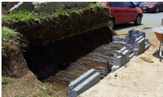
Figura 35. Instalación de primera cama de flejes
