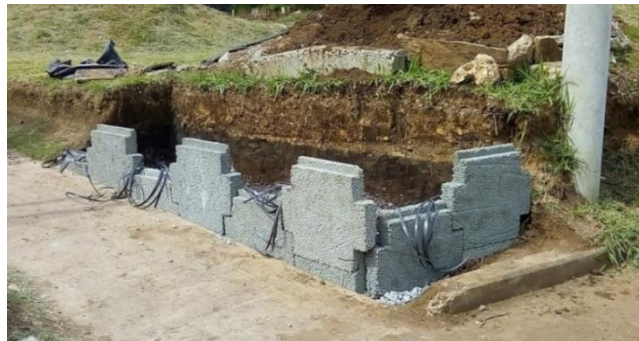
Figura 36. Instalación de la segunda fila del muro
