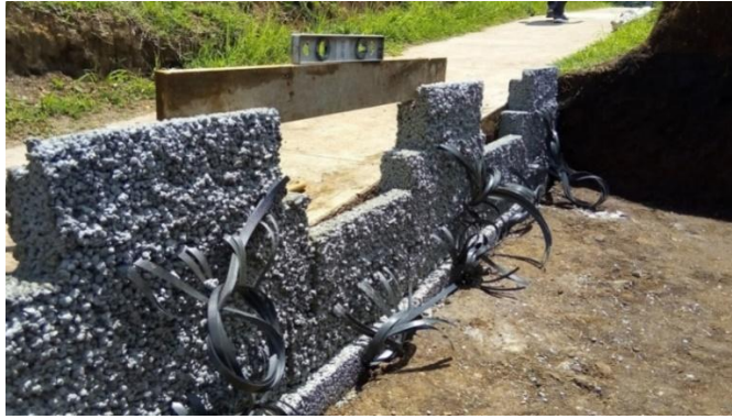
Figura 31. Nivelación de la primera fila del muro
