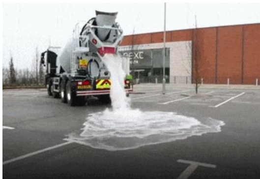
Figura 2. Estacionamiento de concreto permeable
