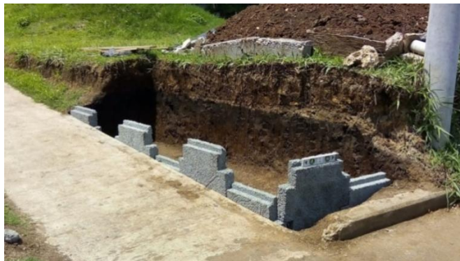
Figura 32. Instalación de la primera fila del muro
