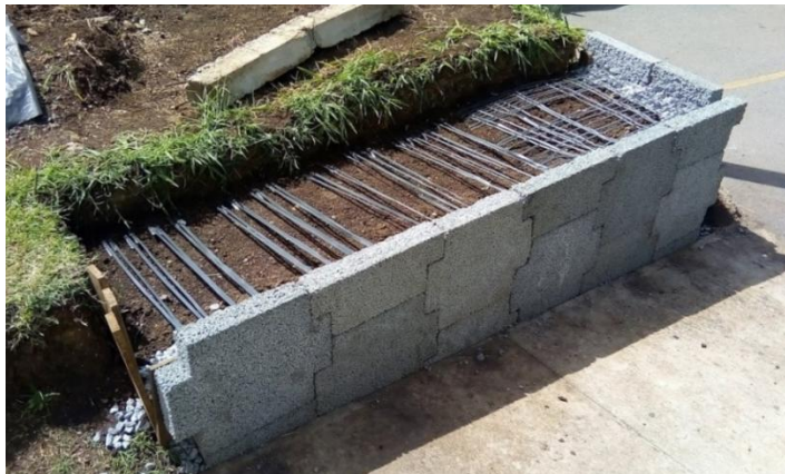
Figura 41. Instalación de cuarta cama de flejes
