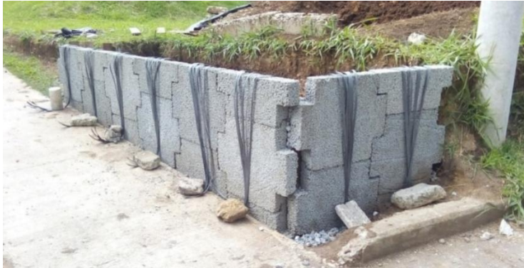
Figura 40. Instalación de la cuarta fila del muro
