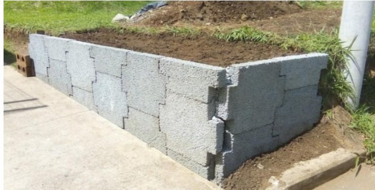
Figura 42. Instalación terminada del muro
