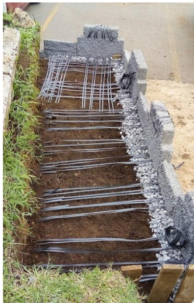
Figura 39. Instalación de tercera cama de flejes
