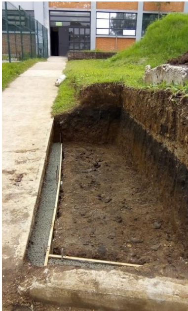
Figura 28. Solera de nivelación
