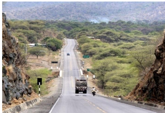
Figura 4. Hombros en carretera de concreto permeable
