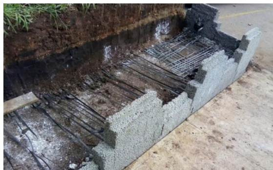
Figura 37. Instalación de segunda cama de flejes
