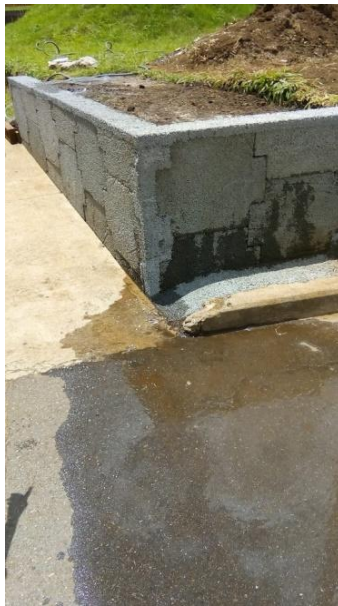
Figura 47. Drenado del agua en el muro
