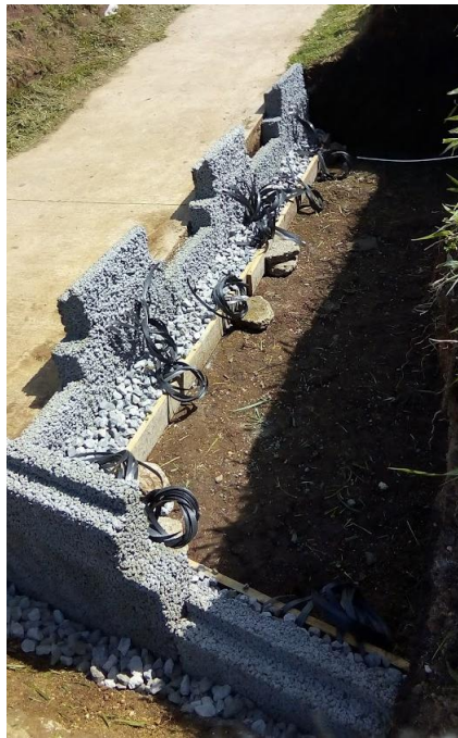
Figura 33. Instalación del drenaje francés
