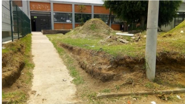
Figura 26. Ubicación para el montaje del muro
