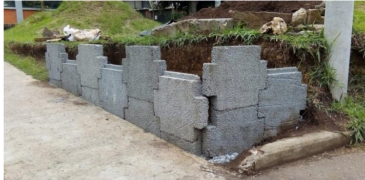
Figura 38. Instalación de la tercera fila del muro
