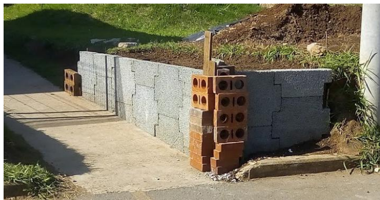
Figura 43. Columna de confinamiento
