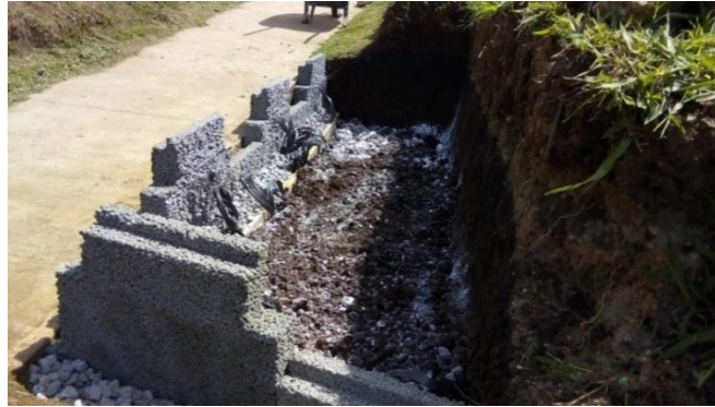
Figura 34. Estabilización del suelo con cal
