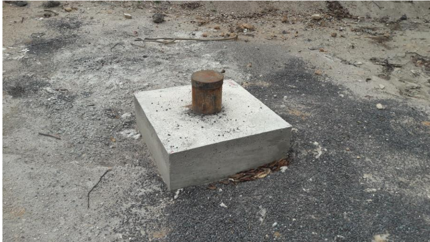
Figura 4. Fotografía boca de pozo
