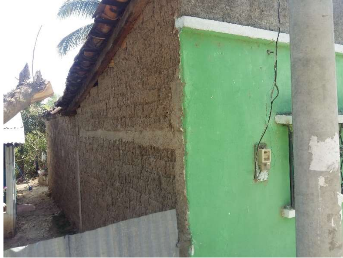
Figura 66. Vivienda de adobe con muro descubierto
