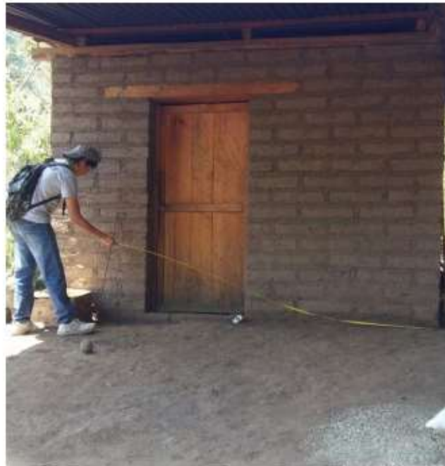
Figura 3. Toma de datos a vivienda de adobe (créditos: Esvin Mayor)
