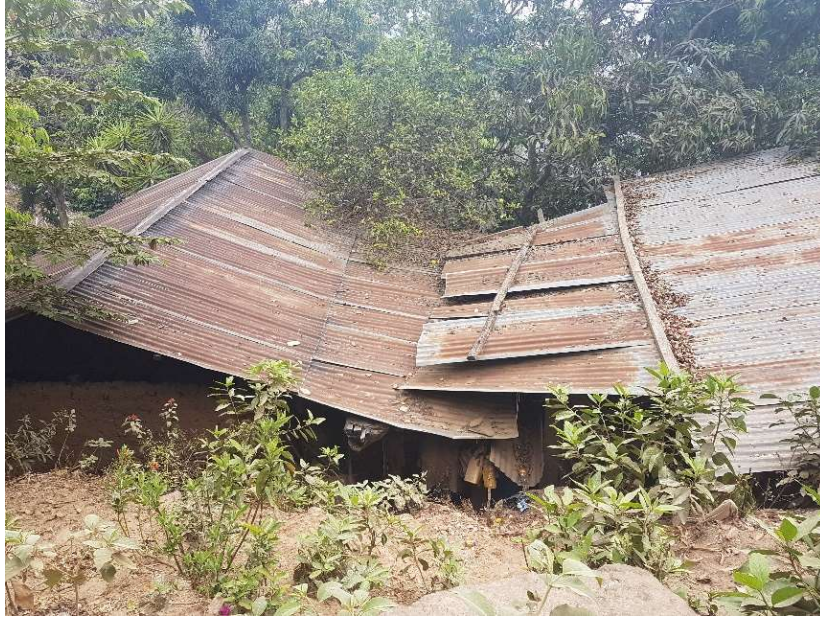
Figura 55. Vivienda ubicada en zonas altas
