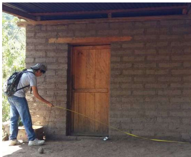
Figura 30. Toma de datos de una vivienda de adobe
