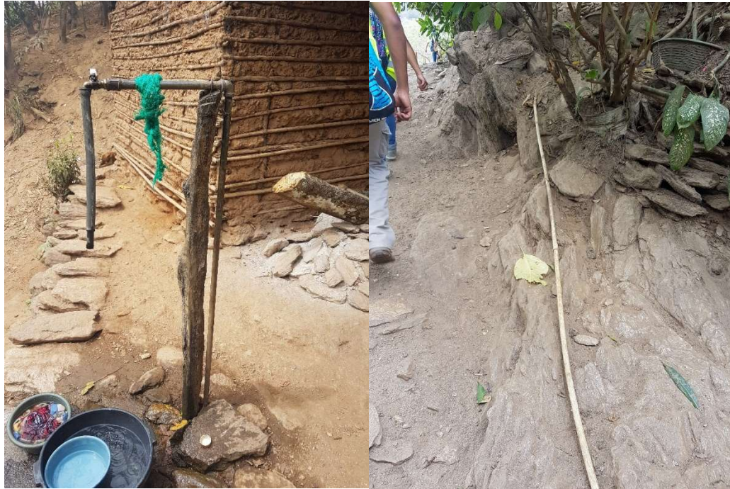
Figura 58. Sistema de tubería en vivienda de bajareque
