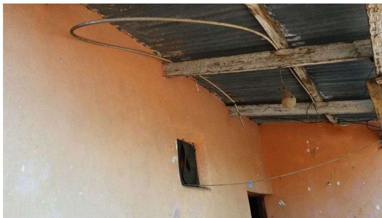
Figura 69. Unión del muro y estructura de techo
