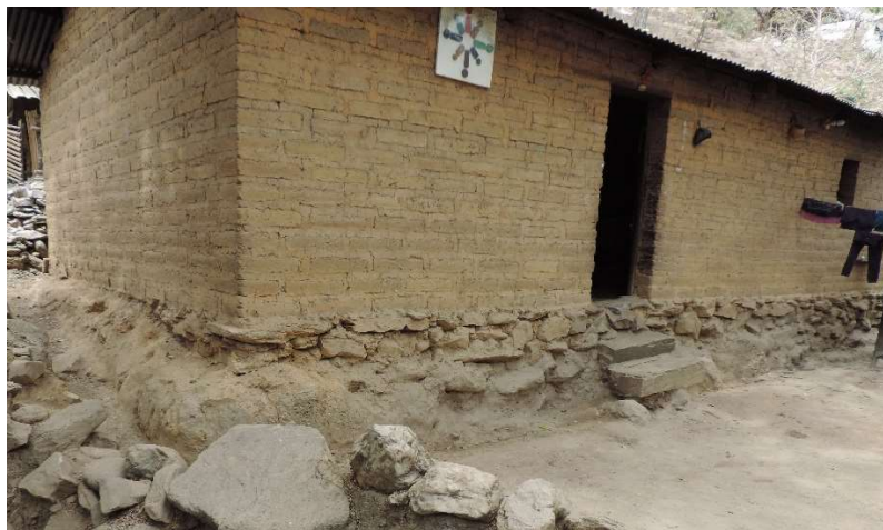
Figura 45. Cimiento en vivienda de adobe
