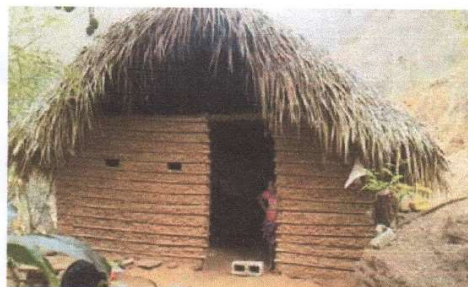
Casa de bajareque en la Aldea el Chanrayo, Municipio de San Agustín Acasaguastlán, Departamento de El Progreso, Guatemala (Créditos: Esvin Mayor)
