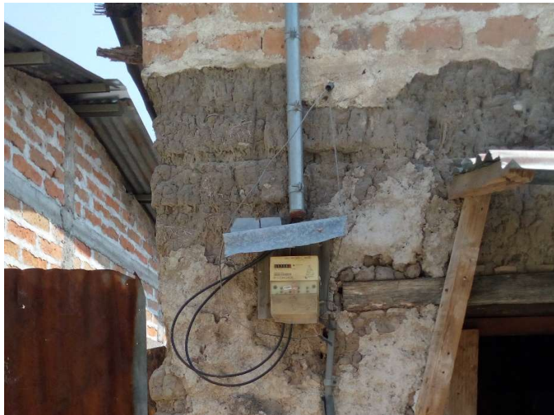
Figura 72. Cimiento en vivienda de adobe
