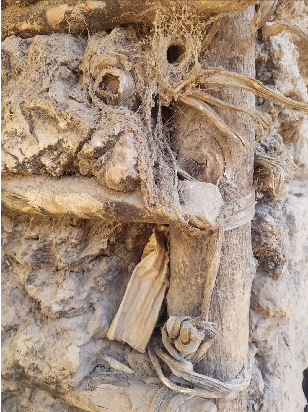
Figura 49. Detalle de amarre en esquina de refuerzo
