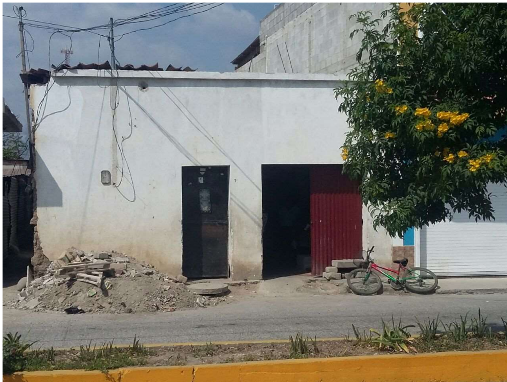
Figura 64. Vivienda de adobe
