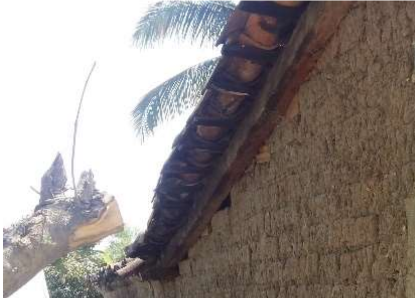
Figura 43. Viga de madera sobre eje de muro
