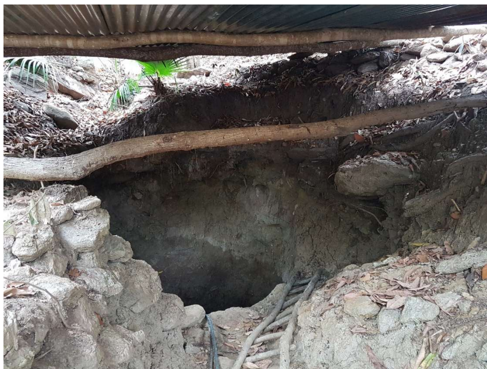
Figura 57. Pozo de captación de agua subterránea
