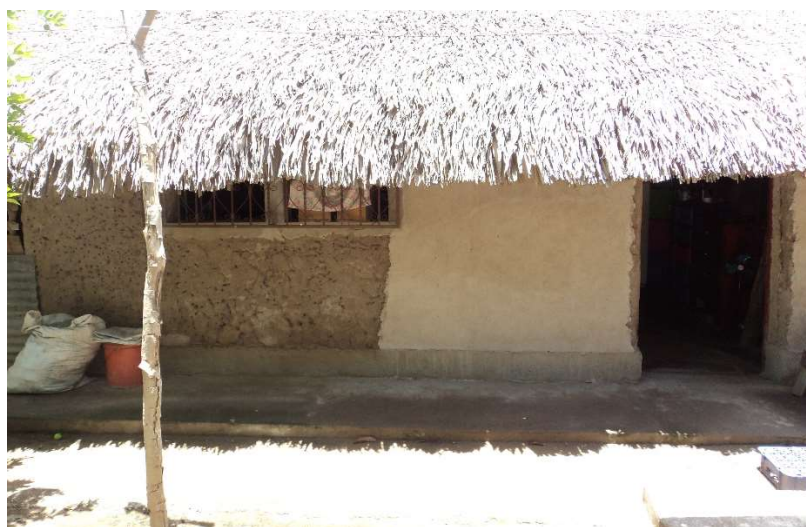
Figura 36. Vivienda de bajareque en proceso de recubrimiento tras aparición de plagas
