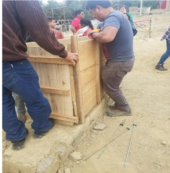
Figura 65. Armado del encofrado
