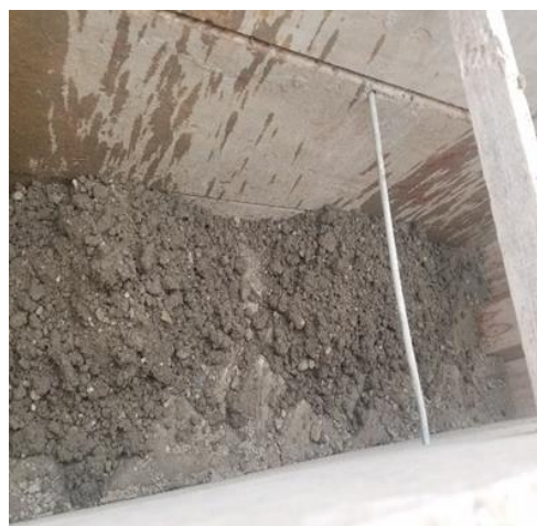
Figura 66. Vertimiento del material
