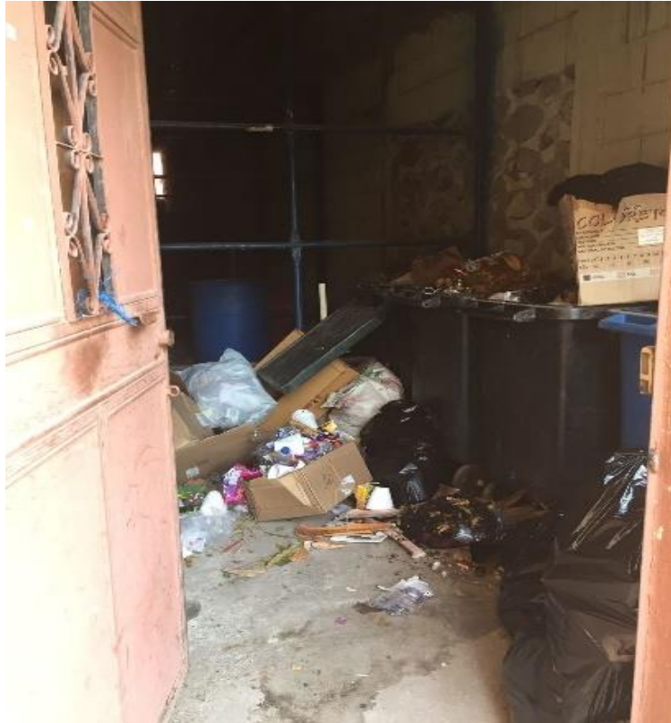
Figura 21. Bodega ubicada a un costado del salón
