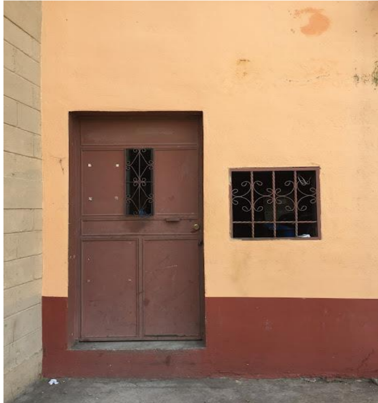
Figura 8. Bodega de almacenamiento ubicada a un costado del salón municipal
