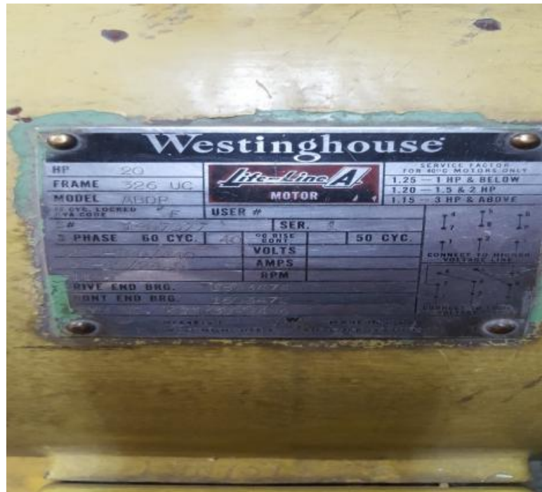
Figura 38. Características de la bomba
