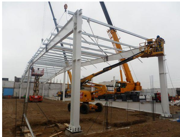
Figura 2. Montaje de estructura de acero
