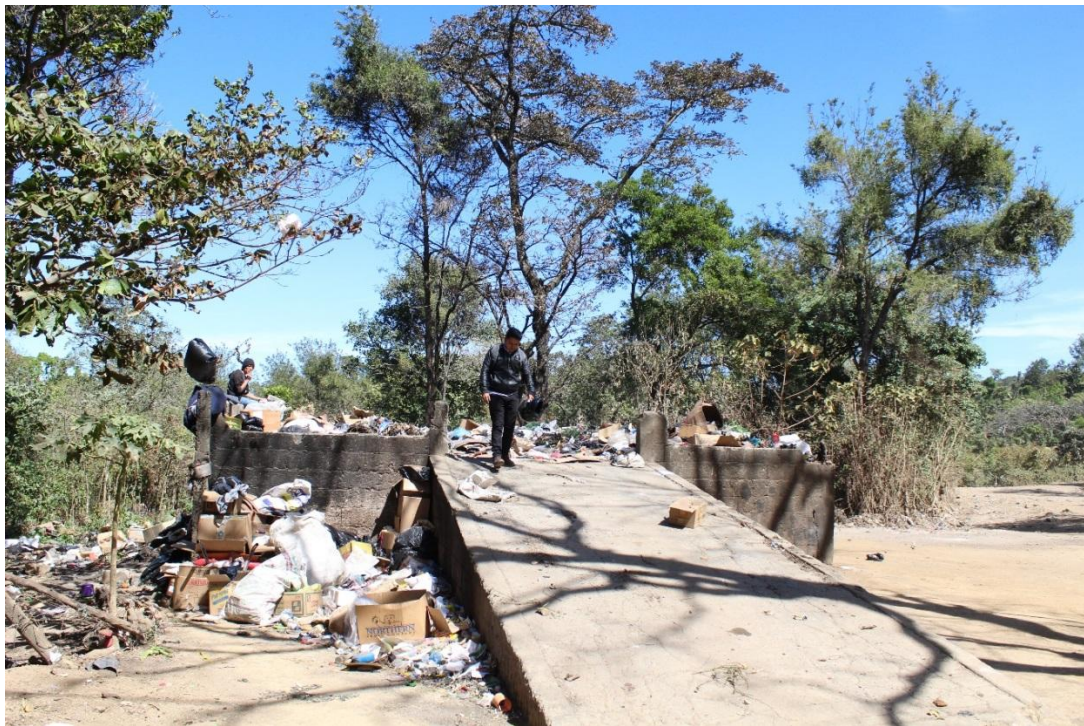
Figura 38. Vertedero actual autorizado
