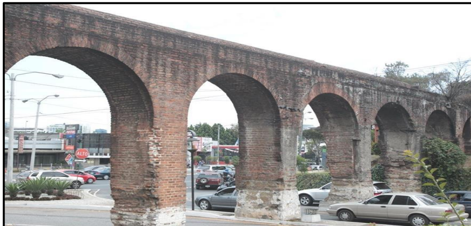
Figura 16. Arquerías que permitían la conducción de la ataujía
