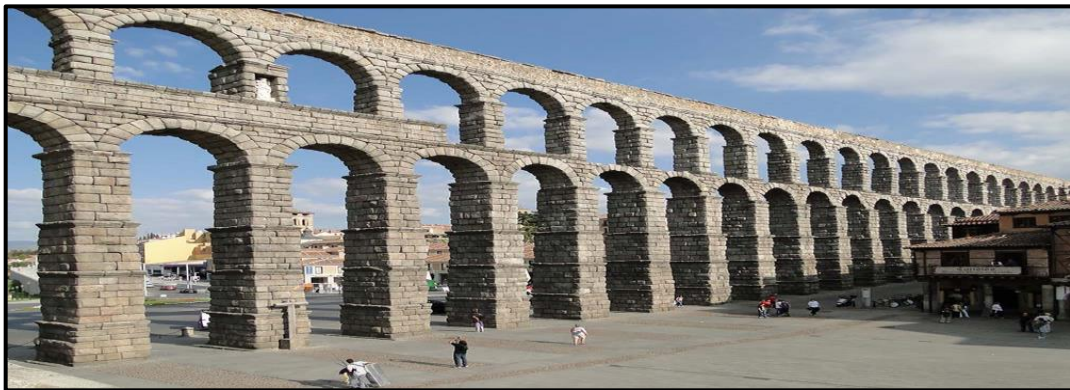
Figura 9. Acueducto romano de Segovia, España
