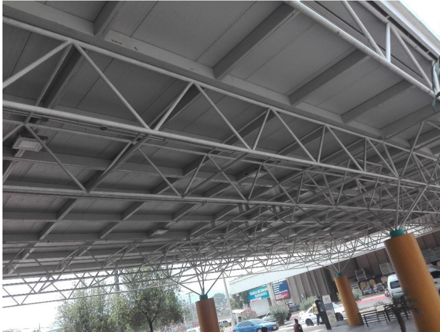
Figura 4. Estructura de techo de centro comercial
