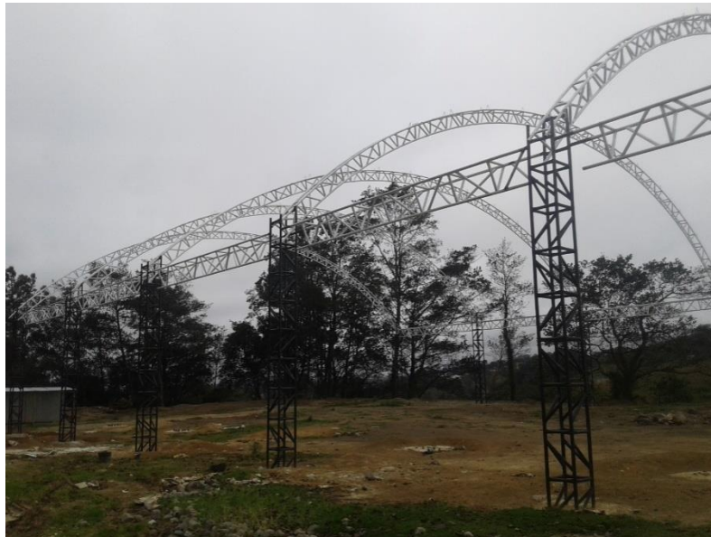
Figura 27. Elevación de estructura formada por joists
