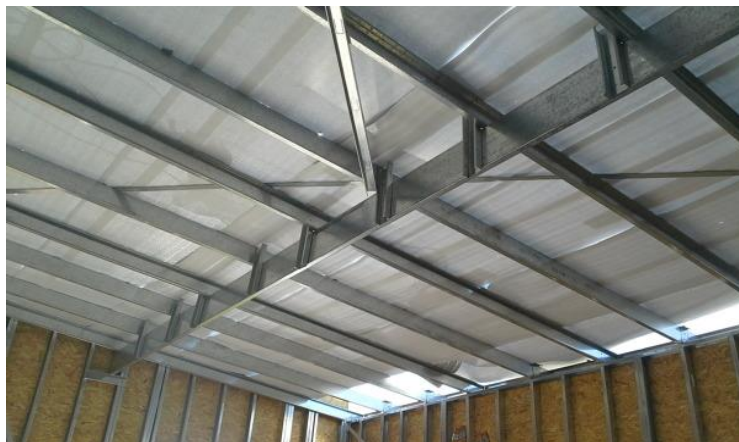
Figura 10. Techo con vigas de acero
