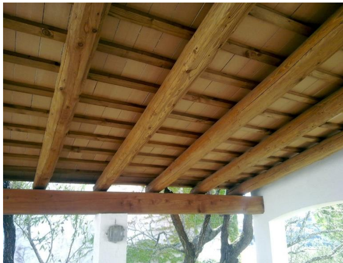
Figura 9. Techo con vigas de madera
