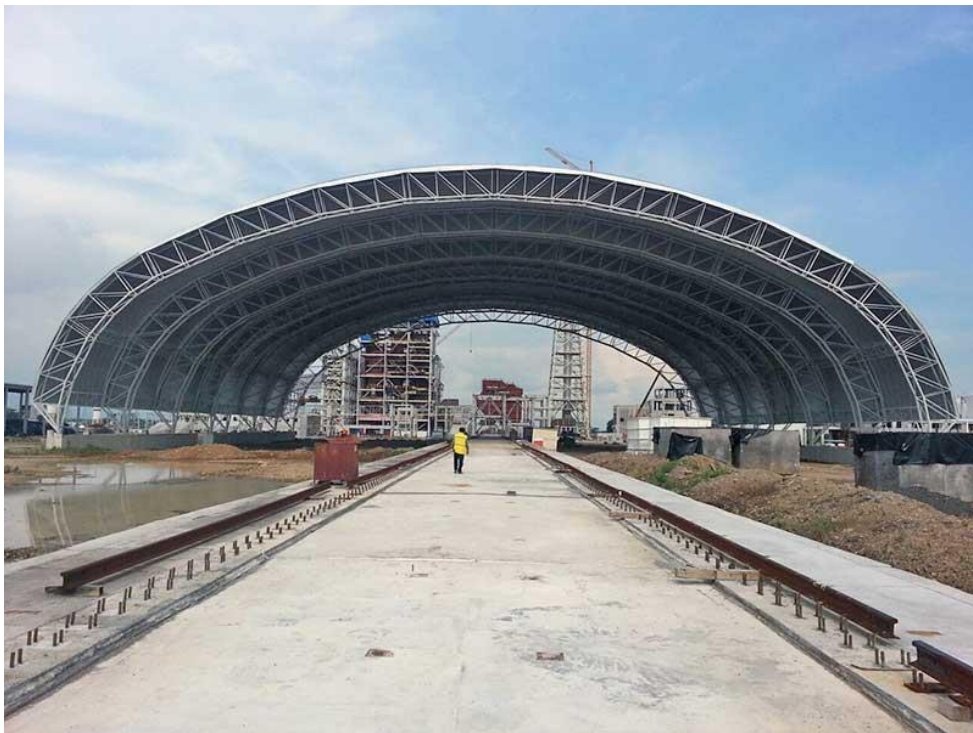
Figura 25. Elevación en estructura en forma de arco
