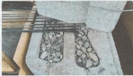
Ilustración 5: Posición de la geomalla y forma de trabajo
