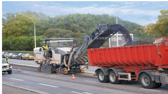
Figura 4. Fotografía de carga de material fresado al camión
