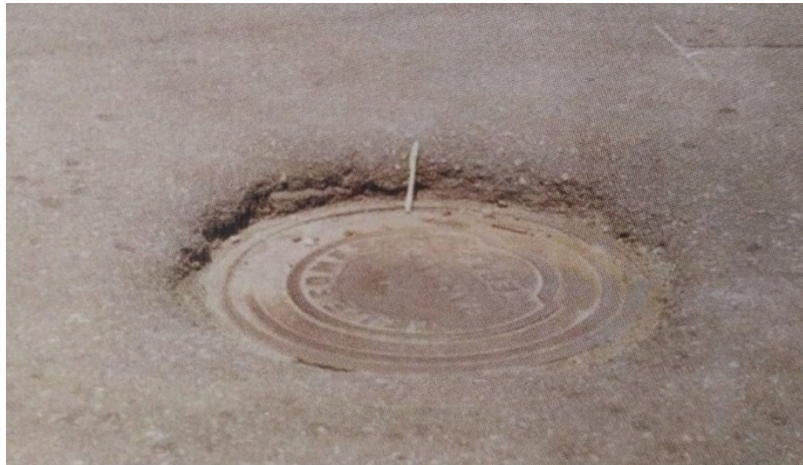
Figura 60. Fotografía de desnivel entre la pista y una tapadera de hierro
