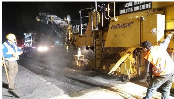
Figura 3. Fotografía nivelación de cilindro fresador
