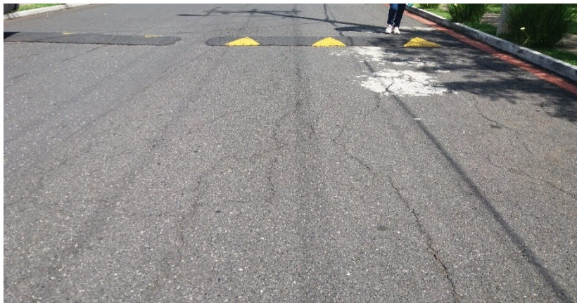
Figura 8. Fotografía de fisuras en bloque
