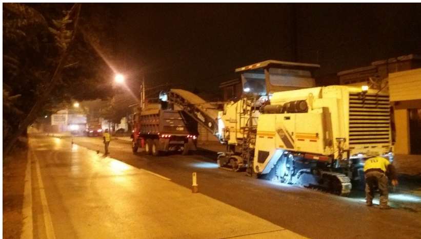
Figura 70. Fotografía de fresado en junta longitudinal
