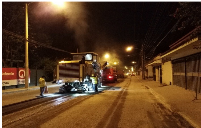
Figura 20. Fotografía de fresado continuo de toda la pista
