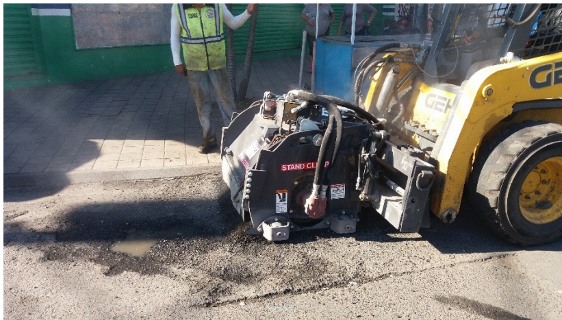
Figura 26. Fotografía de fresado de depresiones
