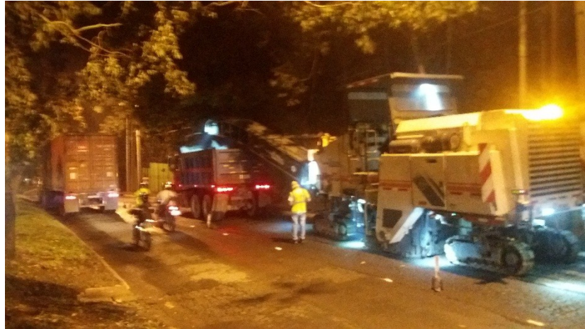
Figura 75. Fotografía de fresado con tráfico
