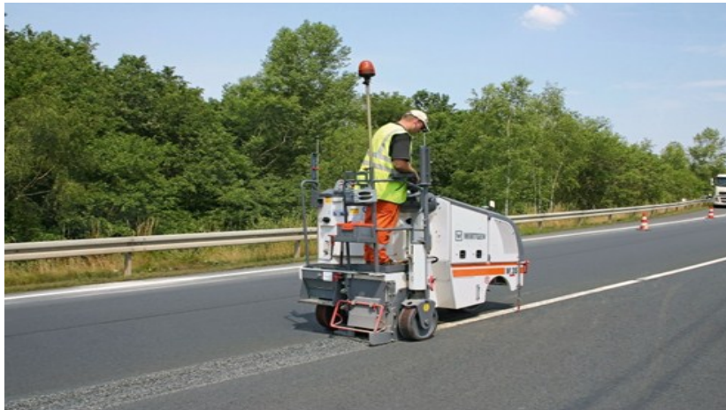
Figura 44. Fotografía de fresado de señalización de carreteras
