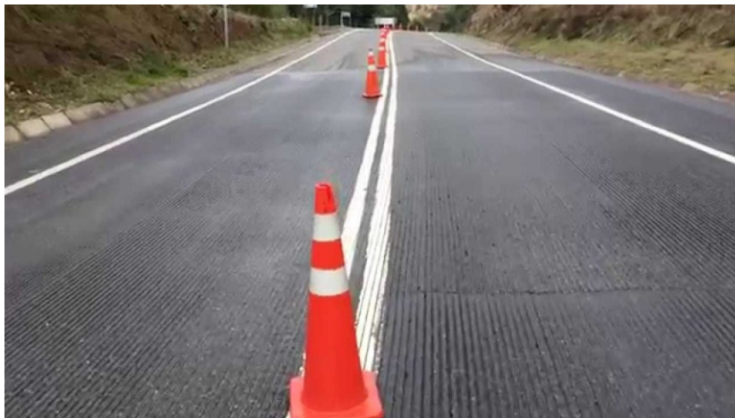
Figura 31. Fotografía de fresado fino, regularización de la pista
