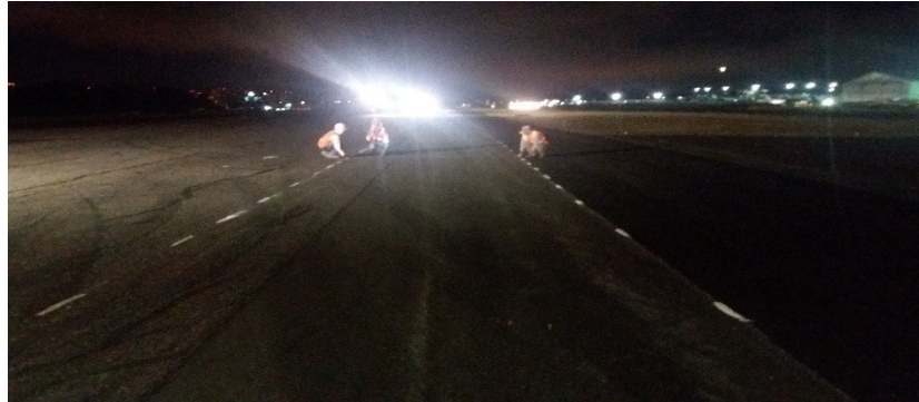
Figura 66. Fotografía de la marcación del área de trabajo
