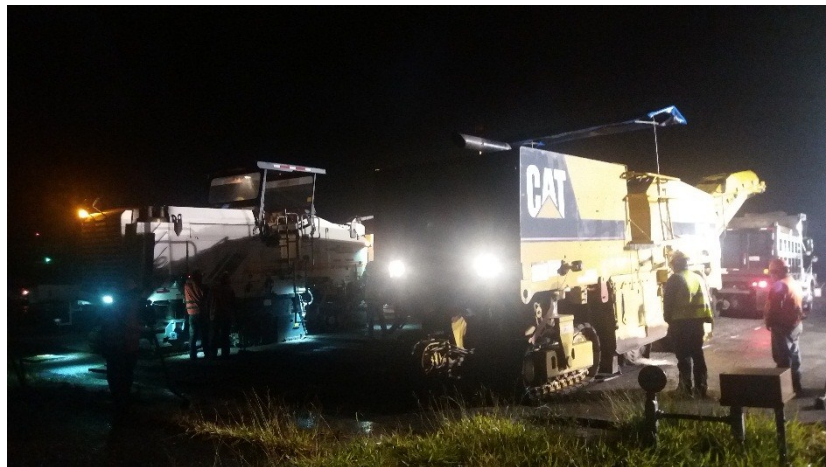
Figura 67. Fotografía de fresado de la pista
