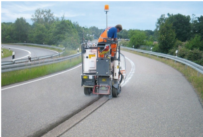
Figura 32. Fotografía de microfresado
