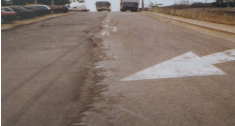
Figura 58. Fotografía de remiende de asfalto sobrepuesto
