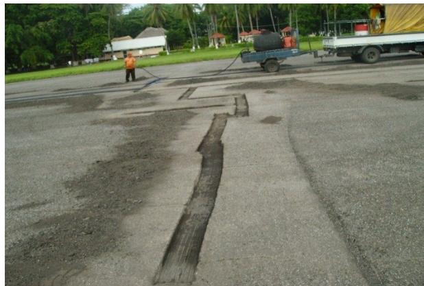
Figura 72. Fotografía de fresado de grietas
