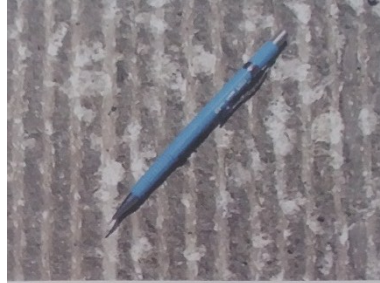
Figura 33. Fotografía de la diferencia entre cortes de fresado
