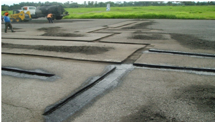
Figura 19. Fotografía de fresado en áreas discontinuas
