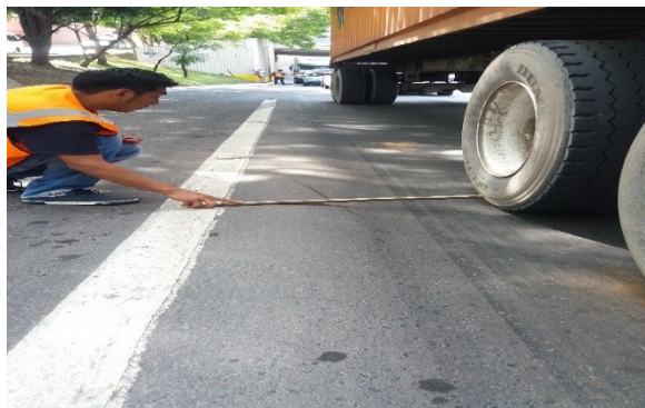
Figura 59. Fotografía de deformación plástica del revestimiento
