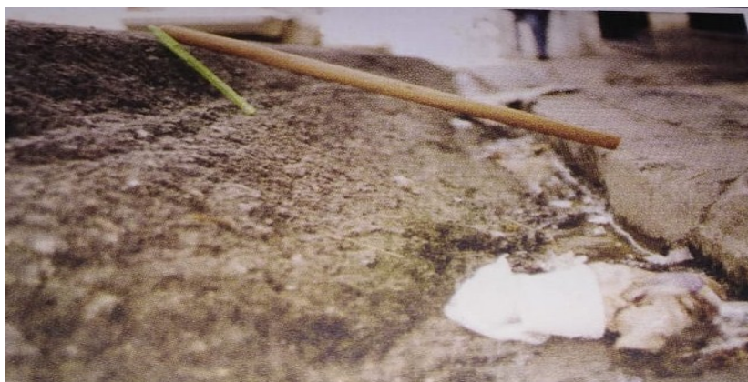
Figura 57. Fotografía de sobreposición de revestimientos asfálticos
