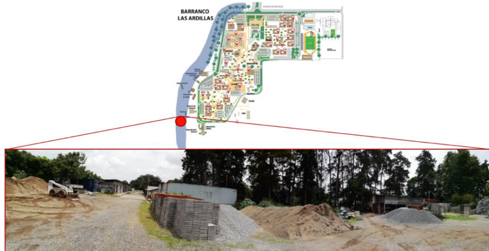
Figura 35. Unidad de Urbanización y Remodelación, USAC
