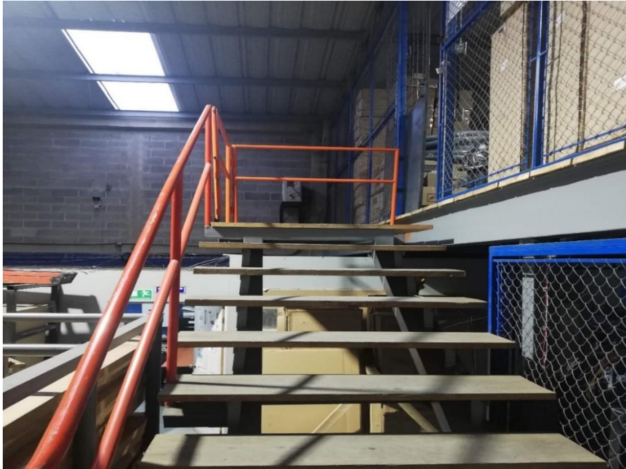
Figura 32. Colocación de barandilla a gradas
