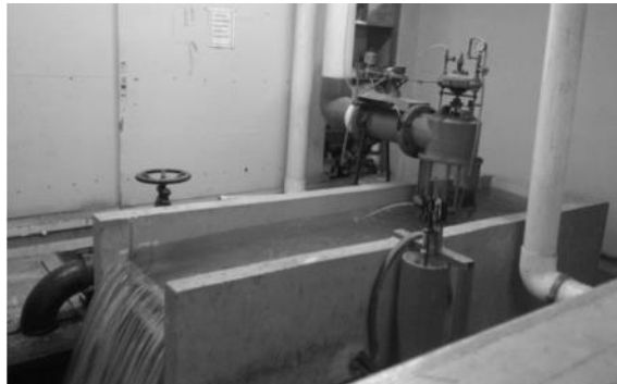
Figura 29. Canal del Laboratorio de Hidráulica de la Facultad de Ingeniería
