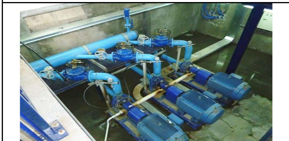
Válvulas de control.
