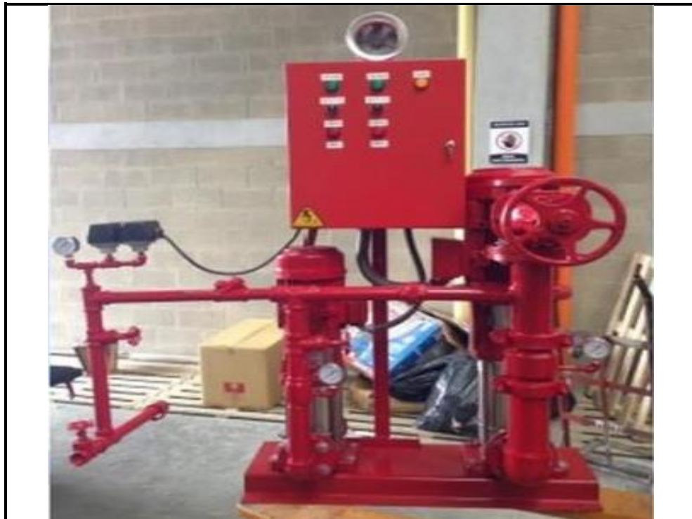
Válvulas de regulación
