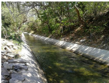
Figura 6. Canal de irrigación
