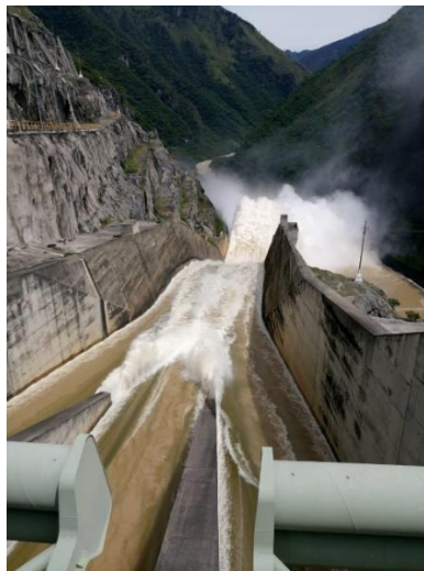
Figura 7. Vertedero de demasía en Hidroeléctrica Chixoy
