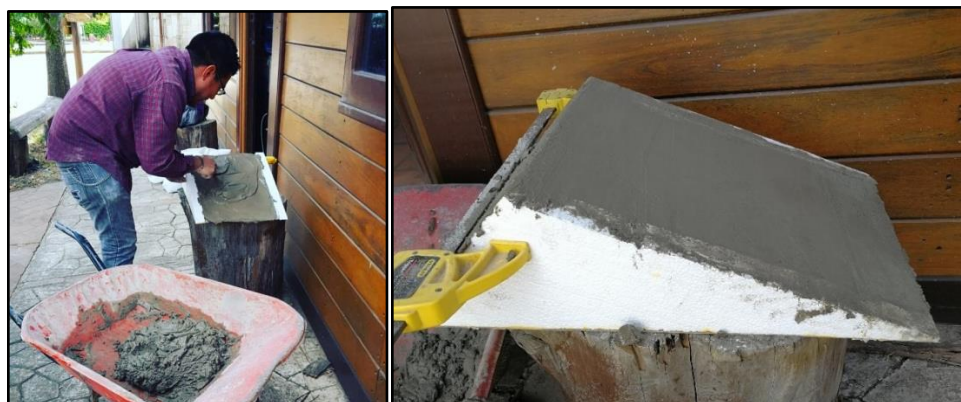
Figura 48. Fundición de prisma triangular
