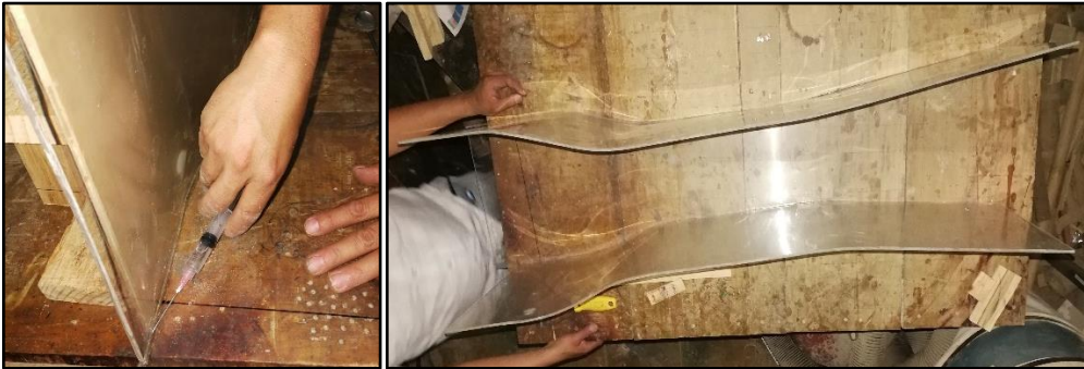
Figura 61. Pegado de piezas de la reducción
