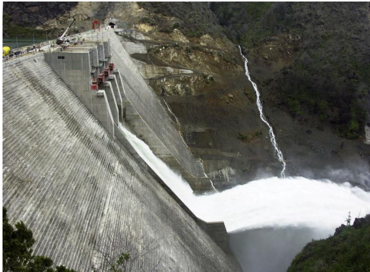
Figura 14. Salto de esquí en la descarga del vertedero
