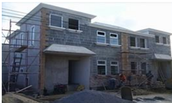
Figura 18. Sistema constructivo megacasa 2g
