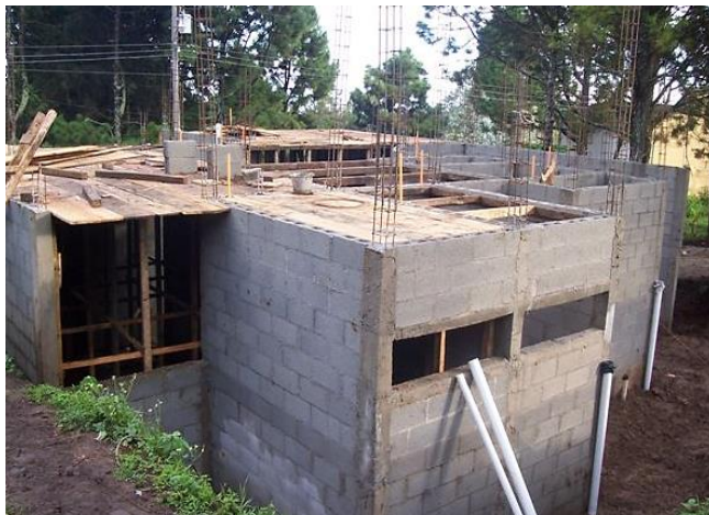
Figura 29. Levantado de muros con armaduras de acero
