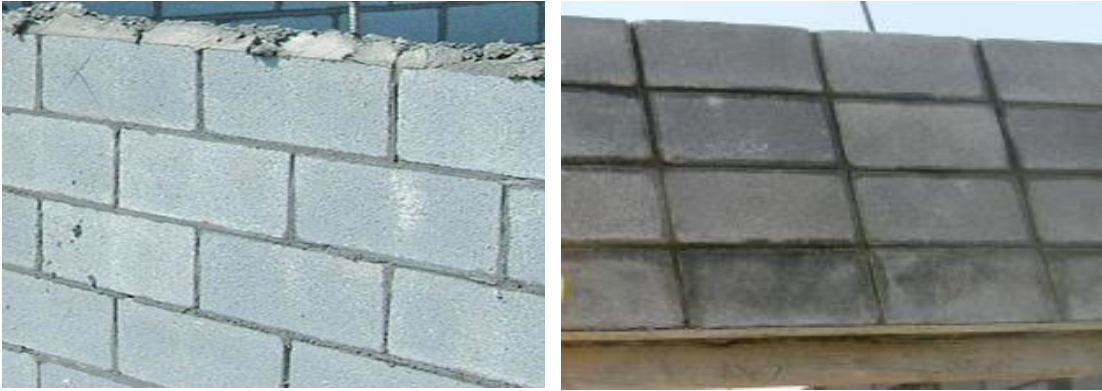
Figura 9. Levantado tipo escalonado y apilado
