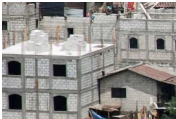
Figura 3. Muros con refuerzo de concreto armado
