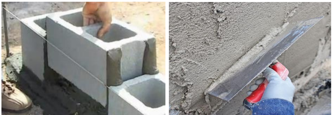
Figura 12. Mortero de levantado y acabados
