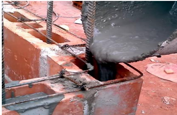
Figura 15. Aplicación de grout en el sistema de mampostería
