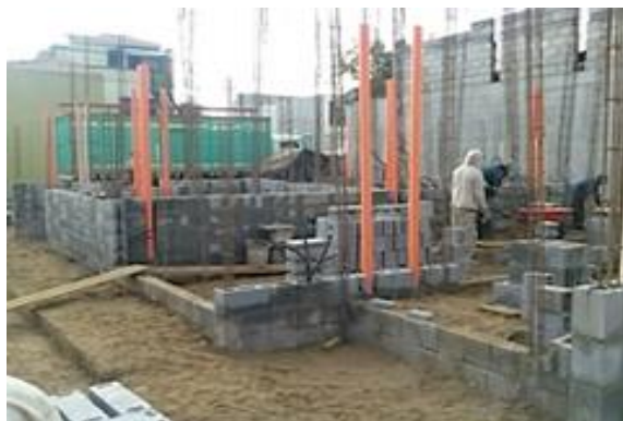
Figura 19. Bloques de concreto y armaduras de acero
