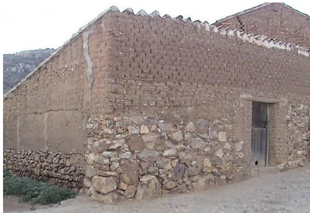
Figura 1. Muro de adobe y piedra
