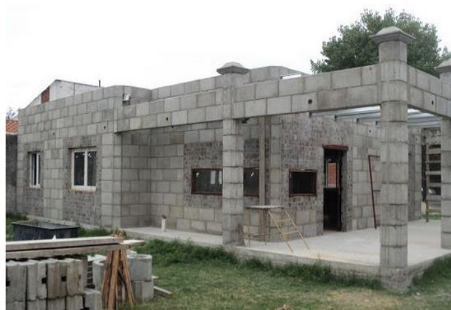
Figura 10. Sistemas de muro en casa de block
