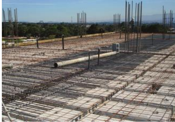
Figura 22. Losa de entrepiso con sistema megalosa 2g
