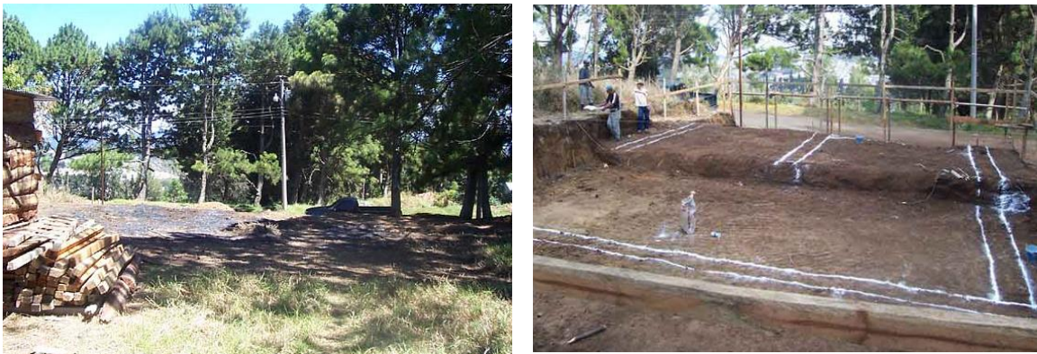
Figura 28. Trabajos preliminares en el sistema de mampostería
