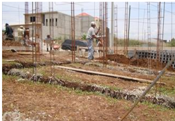
Figura 25. Acero de refuerzo (grado 70) en sistema megacasa 2g
