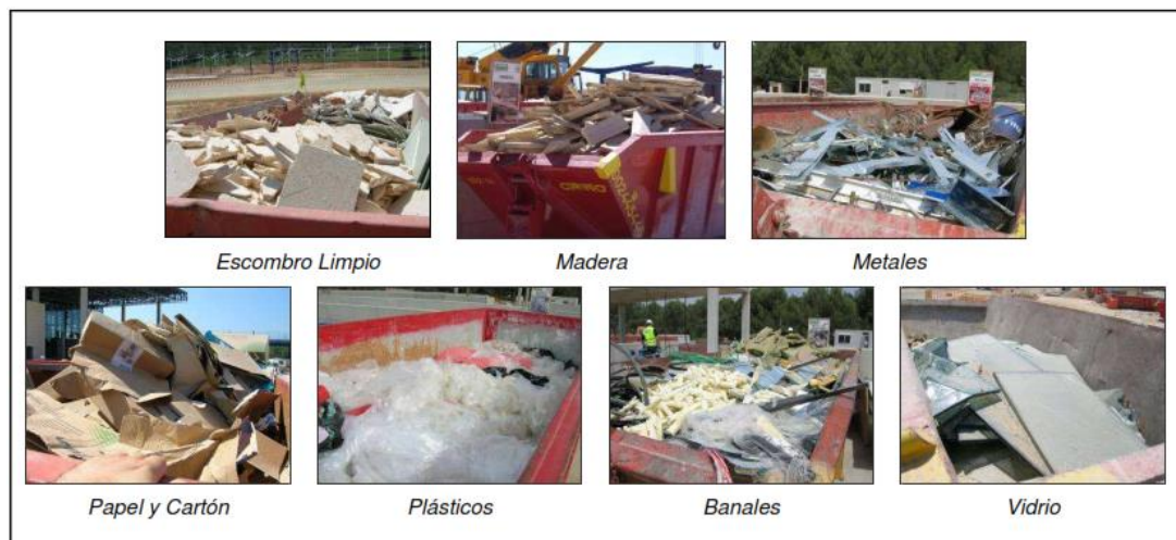
Figura 5. Contenedores para el depósito de residuos
