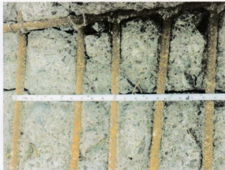
Imagen No. 1 – Espaciamiento de refuerzo circular
