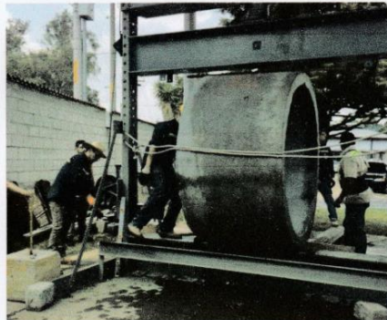
Imagen No. 2 – Colocación de tubo en el marco de carga
