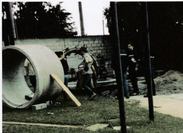
Imagen No. 5 – Proceso de preparación y encamisado de tubo de concreto
