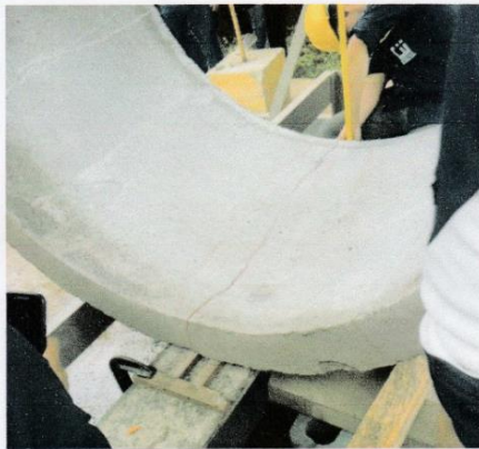
Imagen No. 3 – Aparición de primeras grietas
