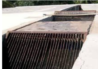
Figura 2. Canal de rejillas
