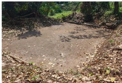
Figura 27. PTAR, caserío Santa Teresita (II)
