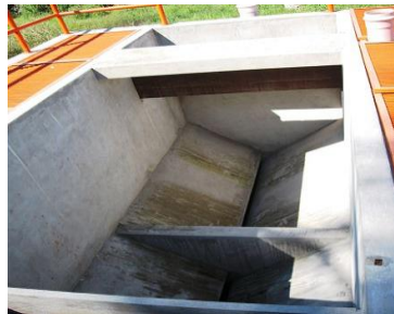
Figura 10. Tanque Imhoff
