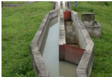
Figura 3. Desarenador
