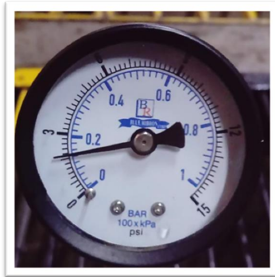
Figura 18. Dato tomado a una (altura del tanque 1,50 m)
