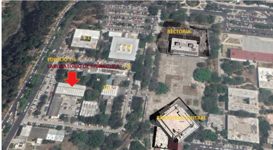
Figura 13. Ubicación laboratorio de hidráulica
