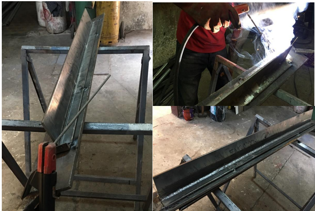
Figura 20. Ensayo del proceso de soldadura con electrodo revestido
