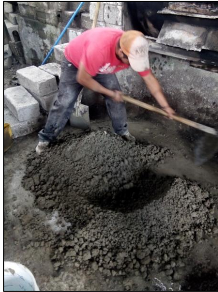
Figura 60. Preparación de la mezcla
