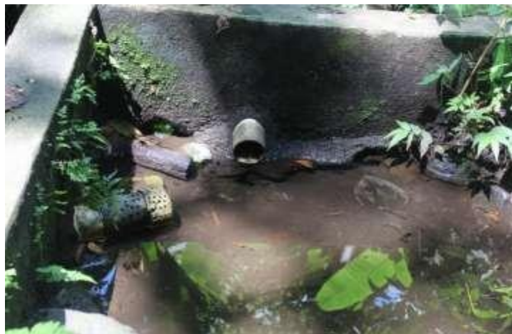
Figura 8. Sitio de captación del río Agua Zarca
