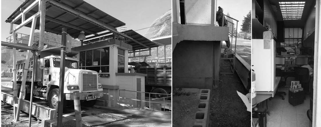
Figura 26. Cabina de operación de báscula antes del proyecto
