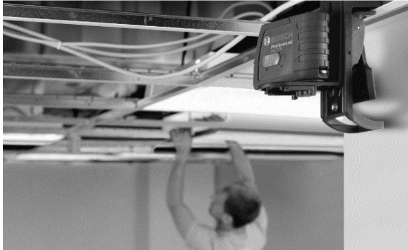
Figura 15. Uso de equipo de nivelación en instalación de cielo falso
