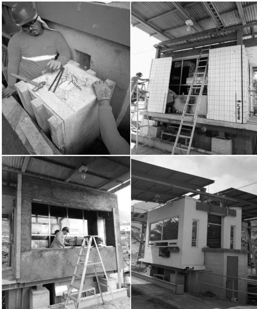
Figura 61. Imágenes del desarrollo de la obra constructiva
