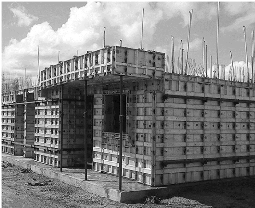
Figura 17. Formaleta de aluminio en construcción de vivienda
