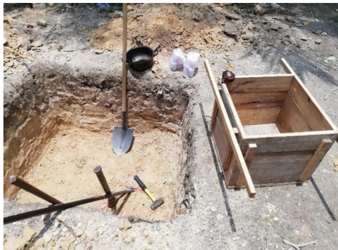
Figura 3. Toma de muestra de suelo 1 pie cúbico
