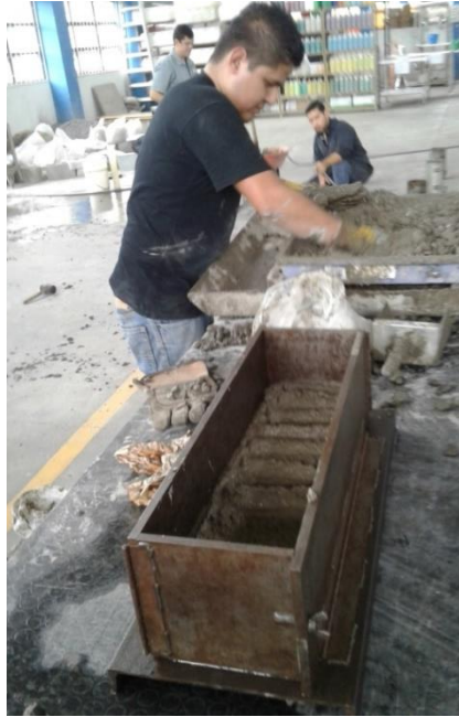
Llenado de viga con el concreto tamizado
