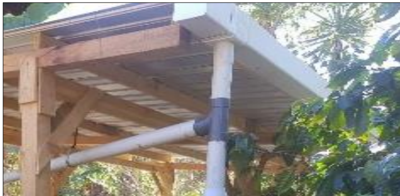
Figura 11. Interceptor de canaletas
