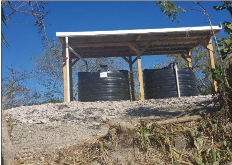
Figura 10. Correcta colocación de canaletas para captación
