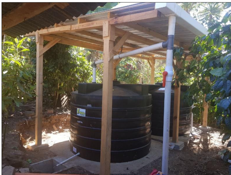
Figura 14. Mantenimiento correcto de sistema de aljibes
