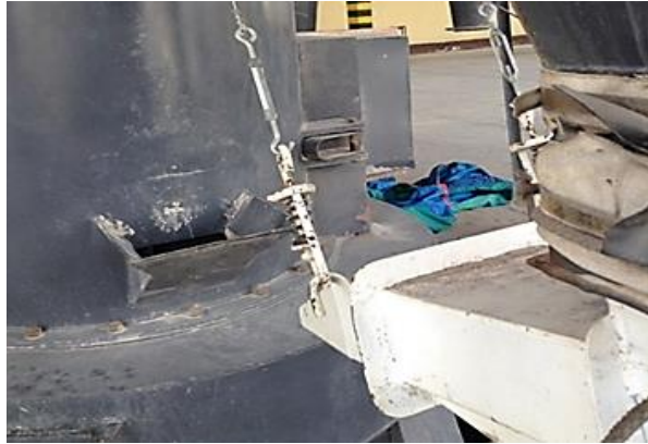
Figura 5. Entrada al área de molienda
