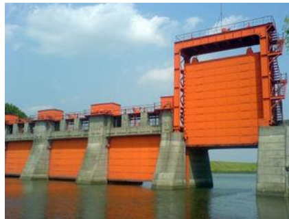
Figura 72. Compuerta plana
