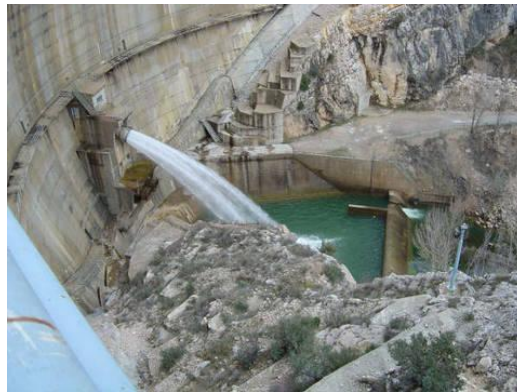
Figura 74. Orificios de acuerdo con la forma de descarga
