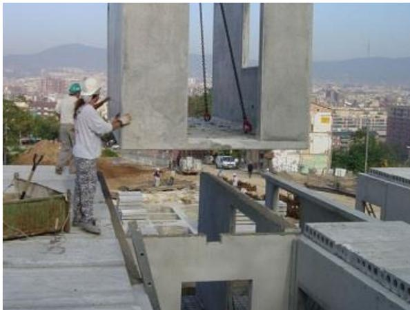
Fuente: Blogger.com. *Sistema constructivo: células tridimensionales* <
