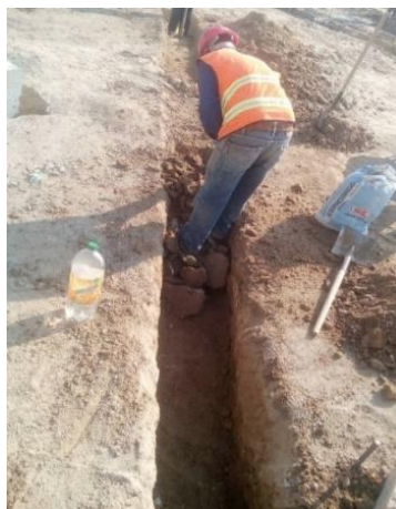
Figura 16. Zanja para tubería
