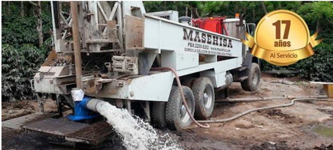
Figura 21. Mantenimiento de pozo mecánico (limpieza)
