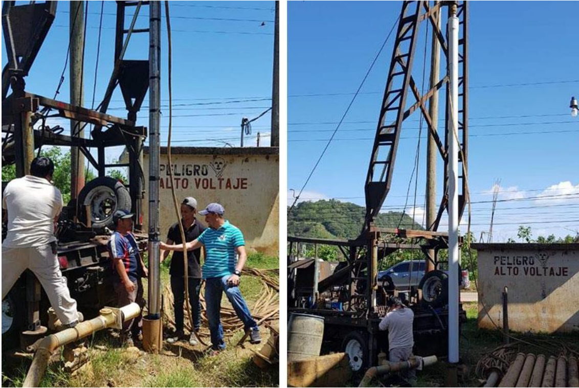
Figura 17. Mantenimiento de pozo de agua
