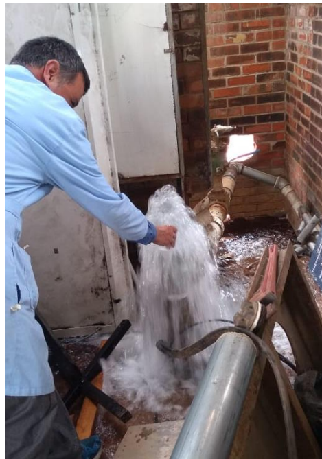
Figura 37. Mantenimiento correctivo pozo y bomba 1
