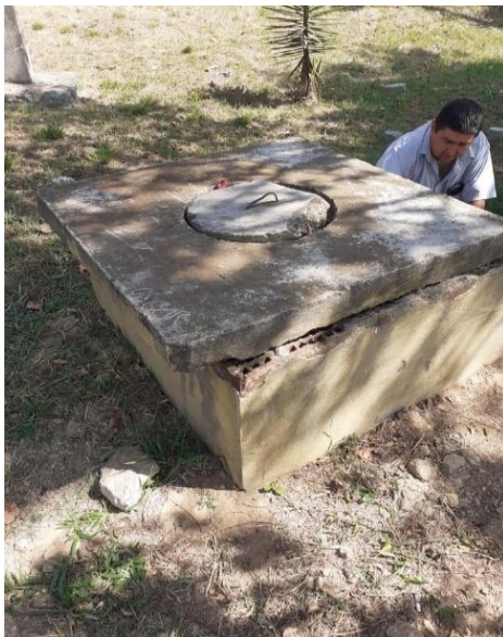
Figura 36. Protección de cubierta y tubería de pozo 2
