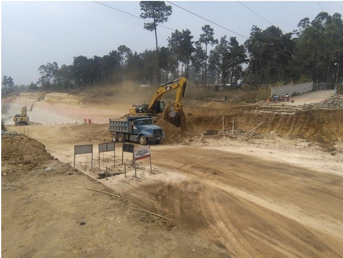
Figura 23. Demolición de pozos y corte de terreno
