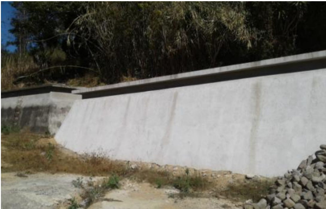
Figura 2. Tanque de almacenamiento
